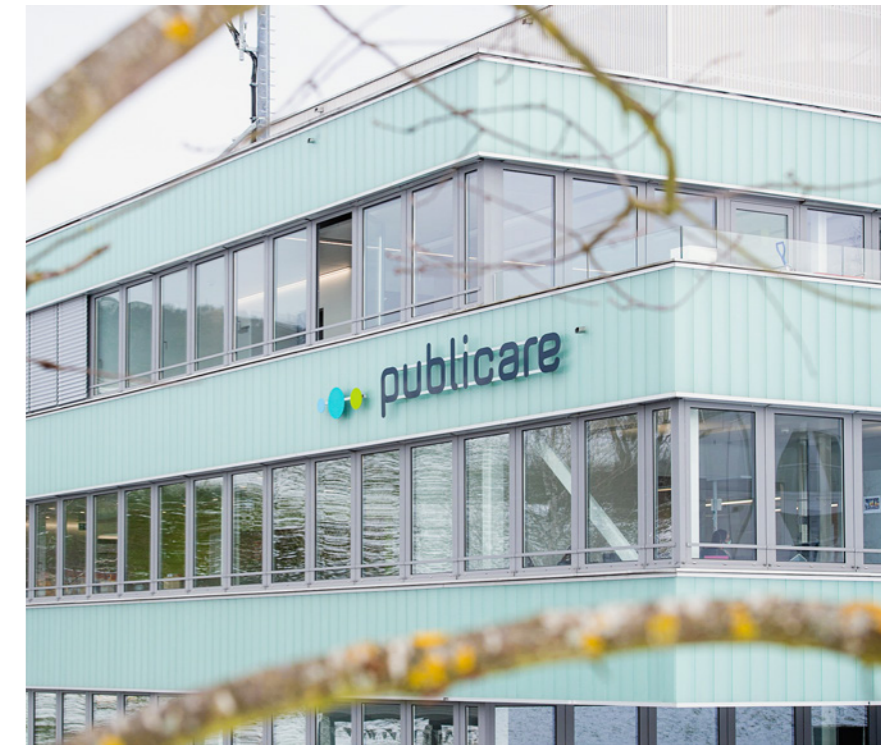
Der Hauptsitz von Publicare in Oberrohrdorf.
